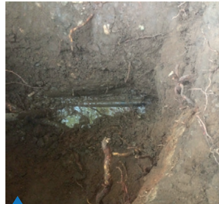
Ouverture dans le sol pour la réparation de la fuite
