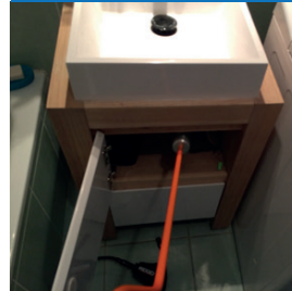
Injection et localisation de gaz traceur.
