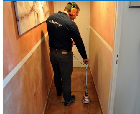
Ecoute électro-acoustique sur canalisations
