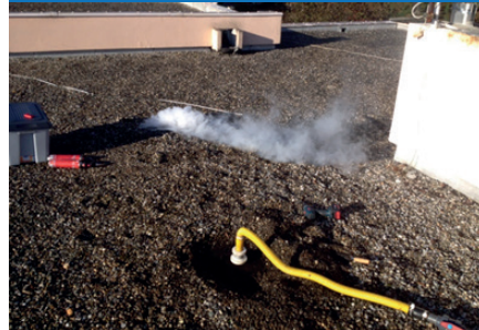
Injection de fumigène dans le complexe d'étanchéité.
