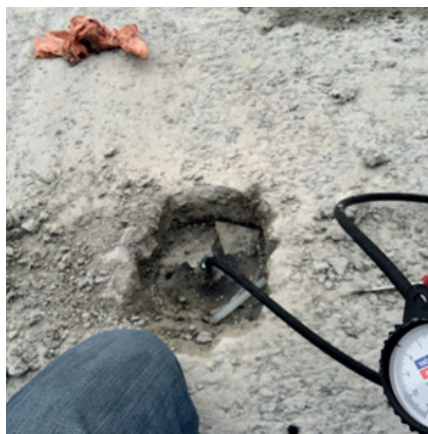
Injection de gaz traceur dans le complexe d'étanchéité.
