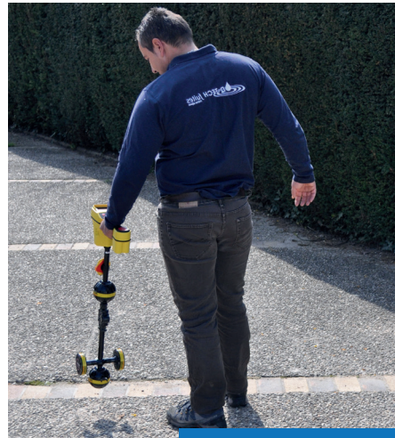
Traçage du réseau
