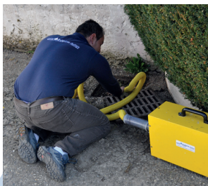
Fumigation du réseau d'évacuation.
