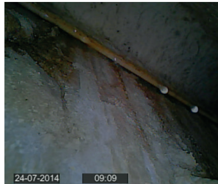
Passage de la camera de poussée dans la canalisation.
